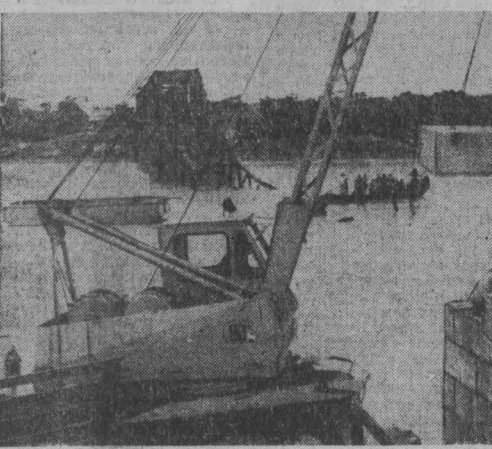
В Демократической Республике Вьетнам продолжается восстановление важнейших железнодорожных мостов на участке Винь-Донхой. Восстанавливаются насыпи, пути, путевое хозяйство. НА СНИМКЕ: восстановление моста Хо-Вьонг. Фото ВИА-ТАСС.
